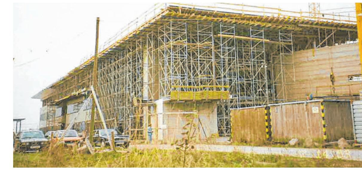
Das Vorarlberger Medienhaus im Bau. KOHLER
